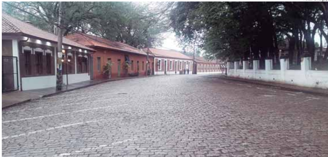
Ciclovia deve passar em trecho de paralelepípedo da avenida Comendador Pedro Morganti
